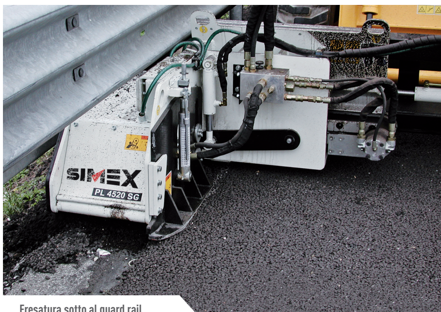
Fresatura sotto al guard rail
