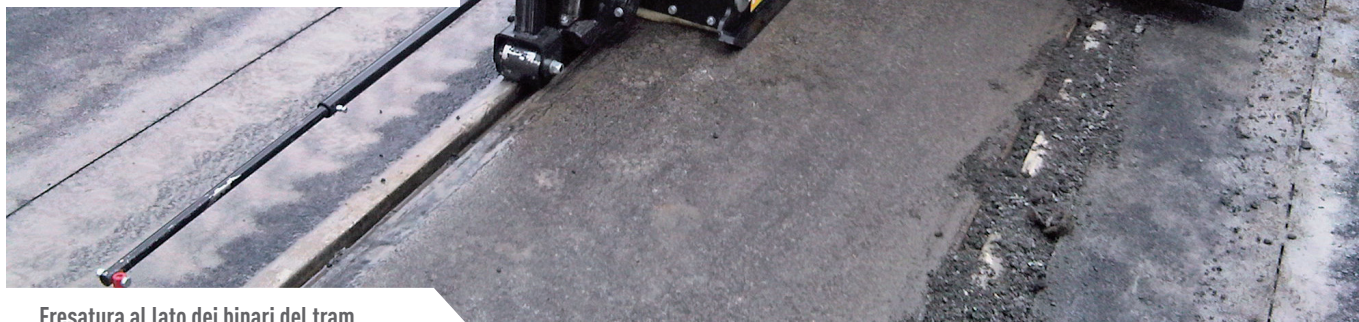
Fresatura al lato dei binari del tram
