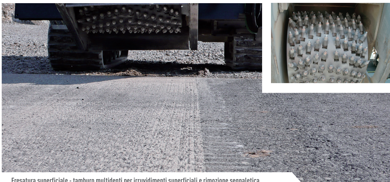
Fresatura superficiale - tamburo multidenti per irruvidimenti superficiali e rimozione segnaletica
